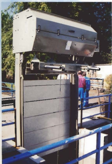
Dégrilleur FJS à éjecteur hydraulique FJS screener with hydraulic ejector
