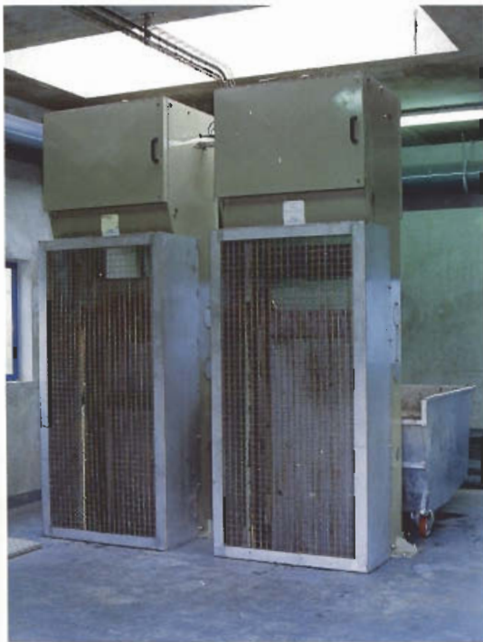
Dégrilleur FJ avec élément de protection CE FJ screener with EC protective cage
