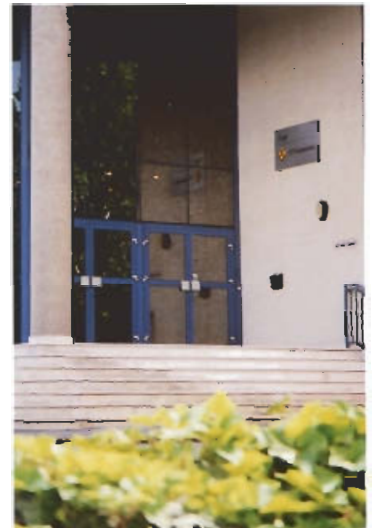
Siège social ITT FLYGT de Nanterre Nanterre head office
