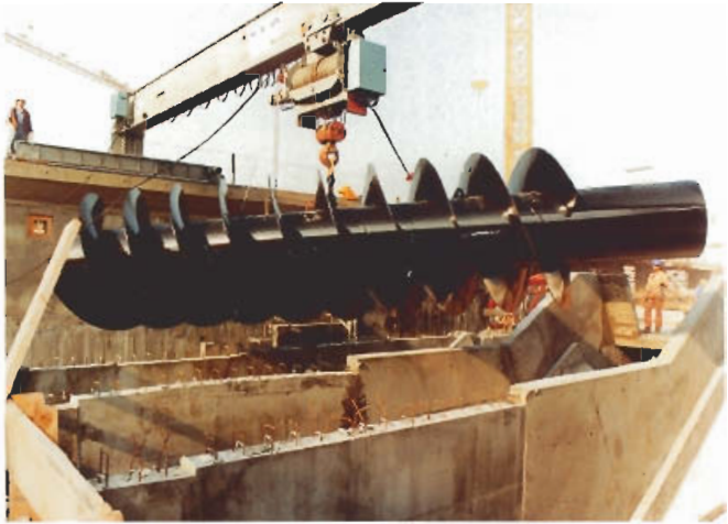
Mise en place d'une vis d'Archimède sur site Installing an Archimedean screw pump on site
